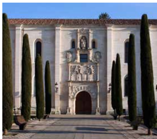
Fig. 1’. Instituto Cardenal López de Mendoza. Burgos. Edificio del siglo XVI
