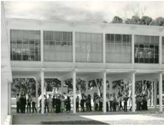
Fig. 7. Detalle de los ventanales de las aulas. Para acceder a las aulas de esta última foto habría que subir las escaleras de la foto anterior y girar el pasillo a la izquierda. Instituto Andaluz del Patrimonio Histórico, bajo Licencia Creative Commons
